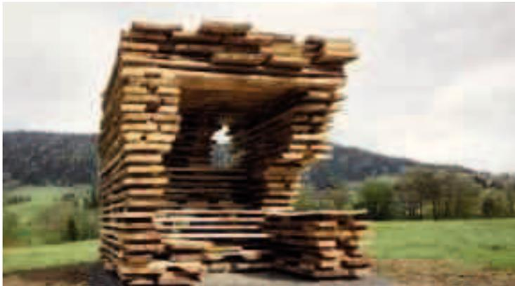
*L'architettura riprende in questo caso una tradizione locale di produzione di tavolati in legno, il risultato è un elemento realizzato mediante elementi impilati.*
