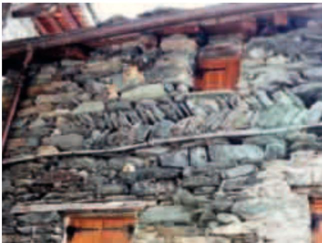
Esempi di corretta realizzazione di tessiture murarie con minimo impiego di malta ed accostamenti di superfici intonacate compatibili.
