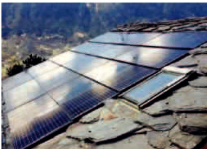
*Esempio di pannelli fotovoltaici semplicemente integrati nel manto di copertura, ma decontestualizzati.*
